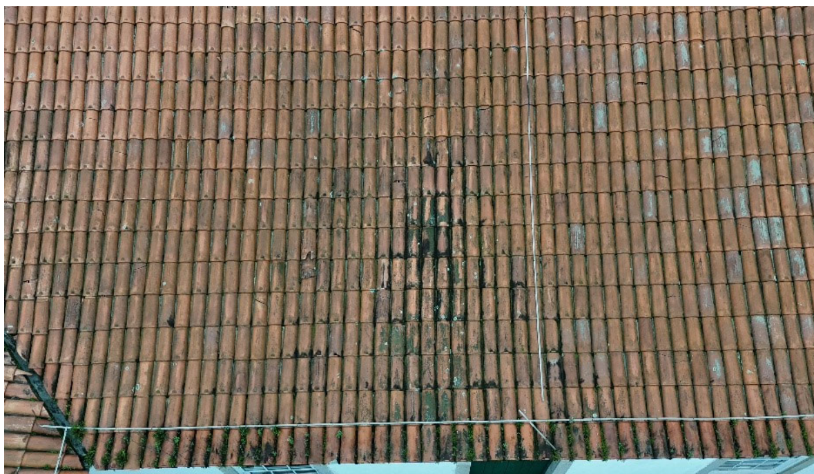
Cobertura Fabrica de Cultura 4.0 de Santos. Fonte: Santos Drone Filmagens Aéreas – 2024
