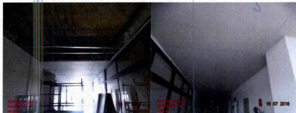
Forro dos corredores
